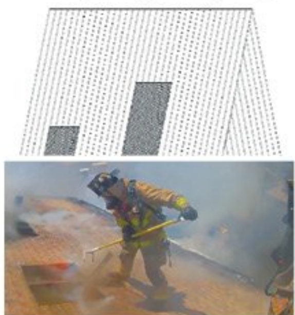
Hình 2: Vị trí phá dỡ để thoát khói trên mái.
