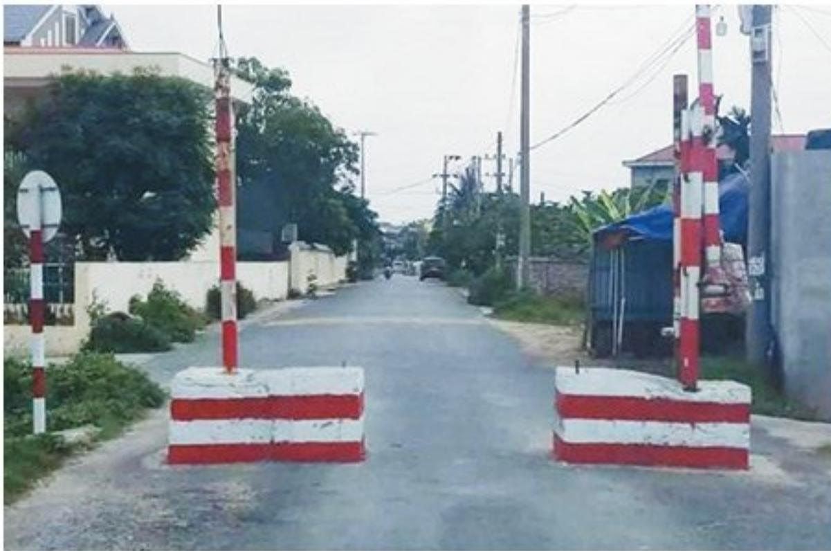
Cột bê tông chắn ngang đường vào huyện An Dương, Hải Phòng.
