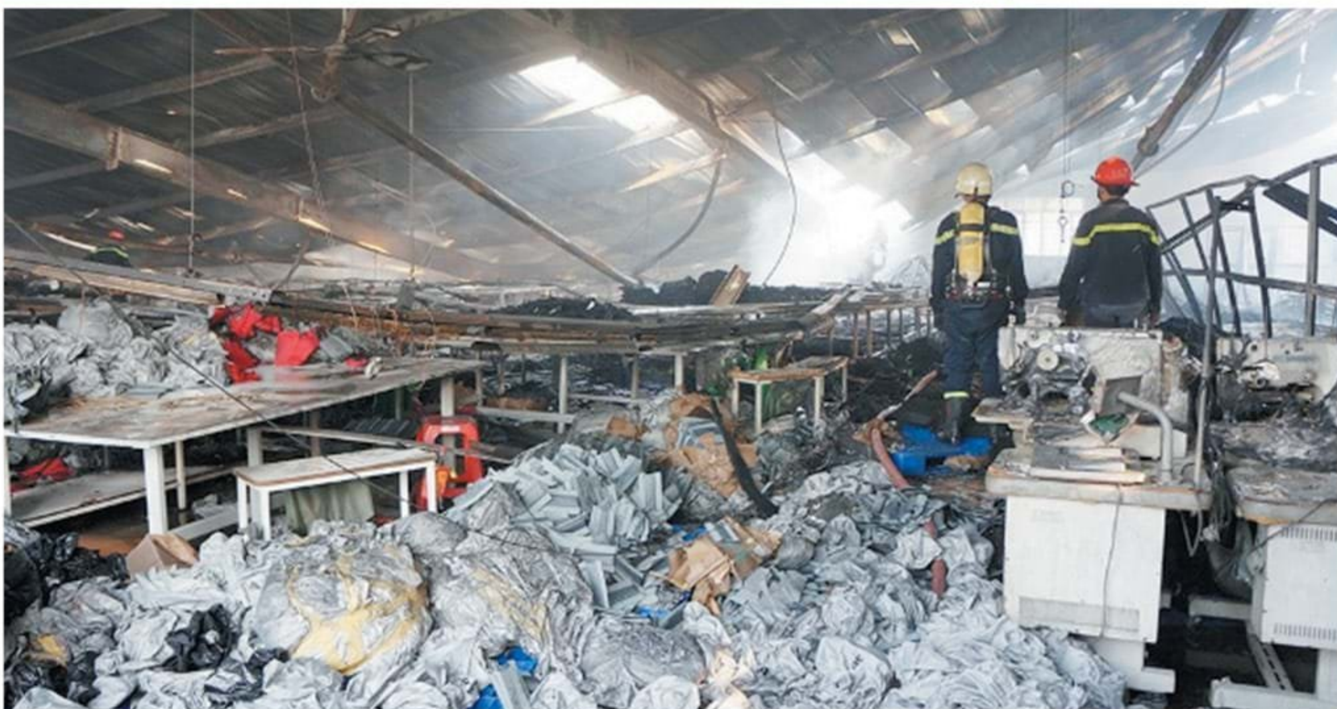
Hiện trường đám cháy tại các cơ sở may mặc.
