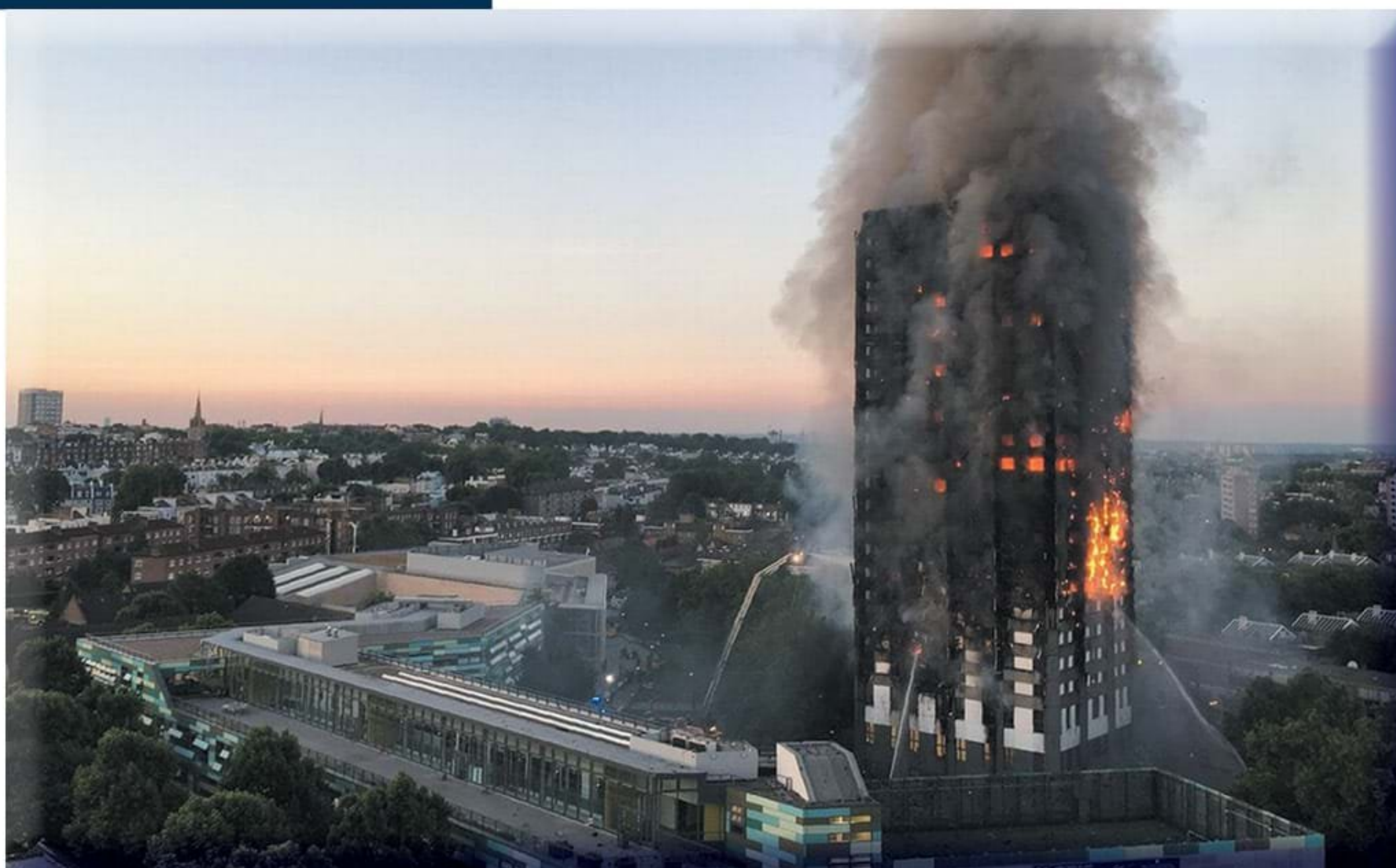
Lực lượng PCCC&CNCH London nỗ lực chữa cháy.
