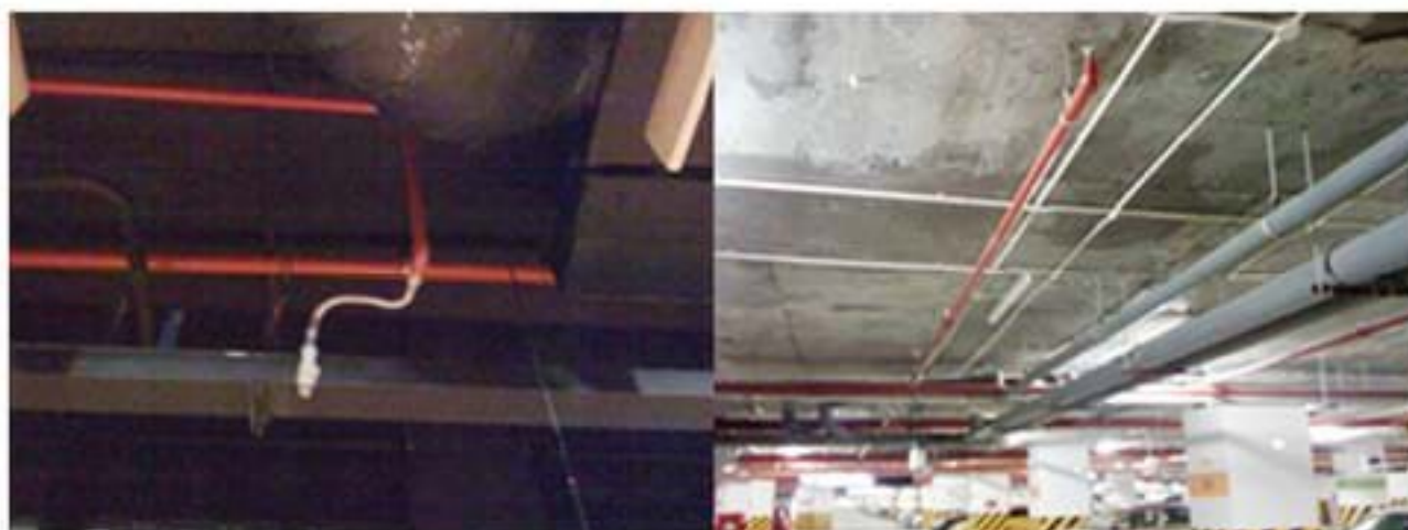
Hình 1- Hệ thống Sprinkler khi sử dụng ống nổi mềm Flex và ống nổi cứng
