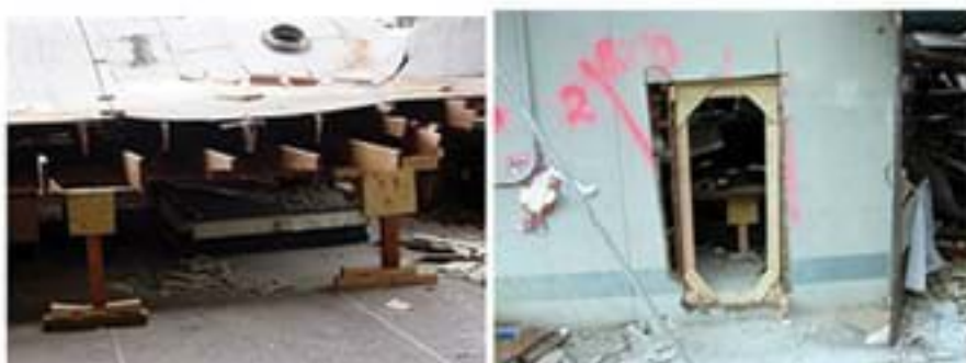
Hình 6: Chống đỡ dạng khung và chữ I
