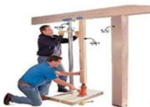
Hình 3: Kích thủy lực chống đỡ
