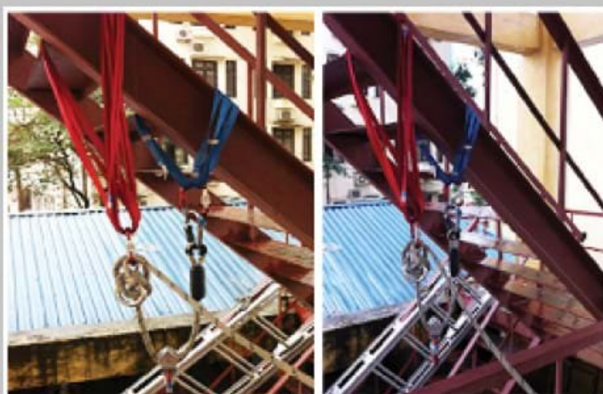
Hình 4: Sử dụng dây mềm tạo điểm neo cố định cứu người từ dưới lên
