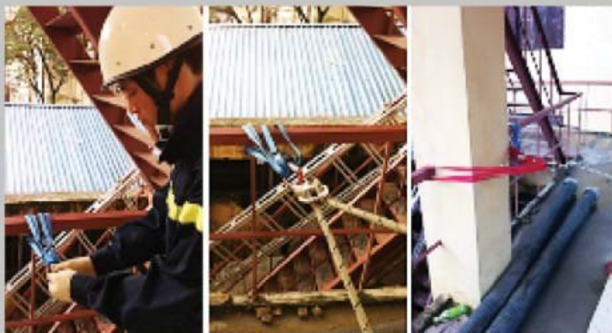
Hình 3: Sử dụng dây mềm tạo điểm neo cố định giữ dây thả người
