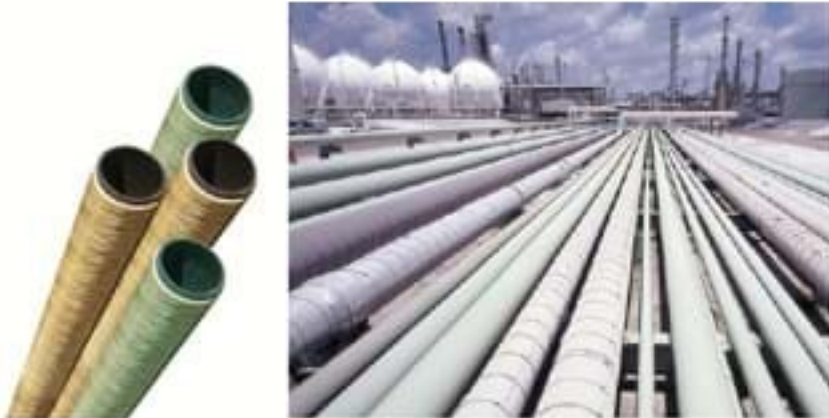
Hình 1: Ống trụ có lớp bọc cách nhiệt và một số đường ống dẫn dầu có lớp bọc cách nhiệt
