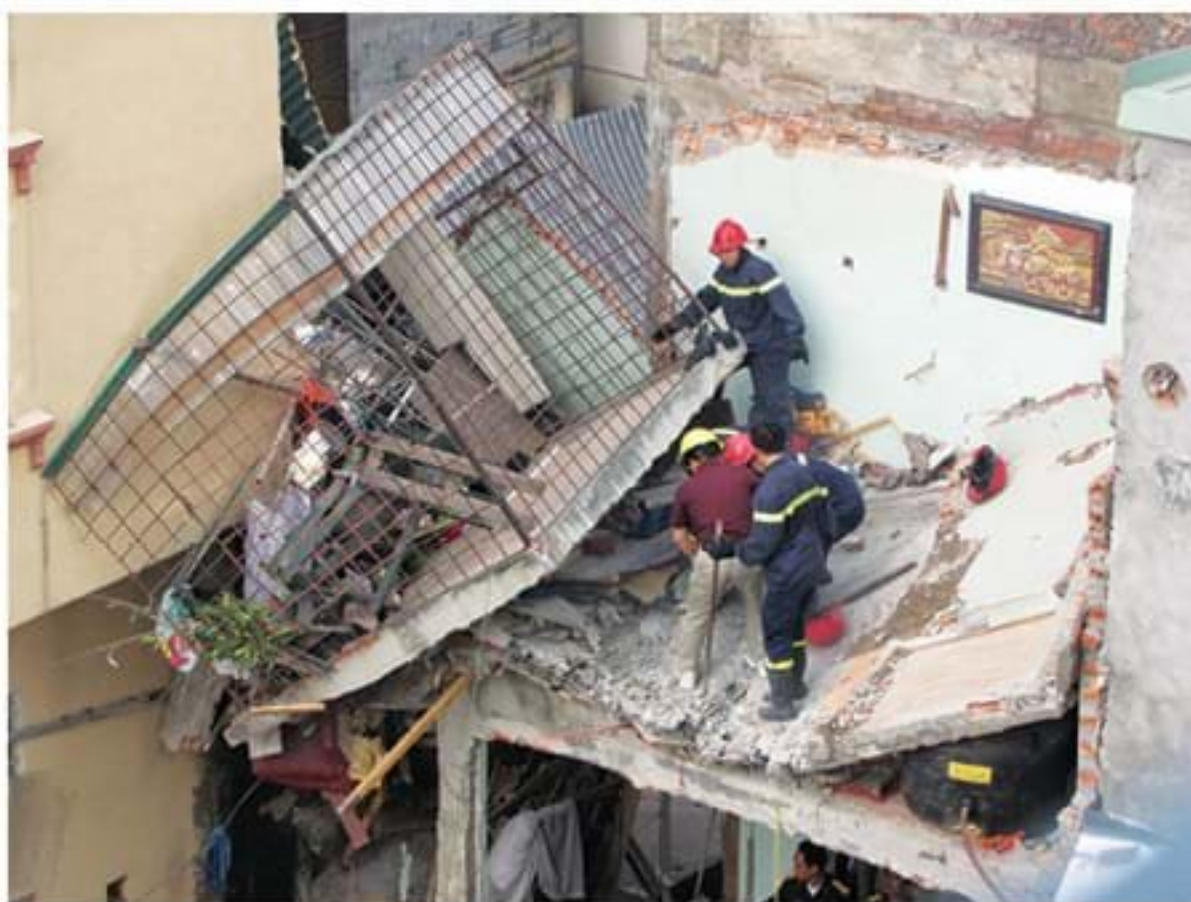
Hiện trường vụ nổ khí gas tại phố Tạ Quang Bửu, Hà Nội năm 2011
