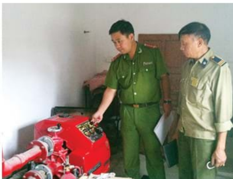
Phối hợp kiểm tra phương tiện chữa cháy tại chỗ ở Ga Giáp Bát.
