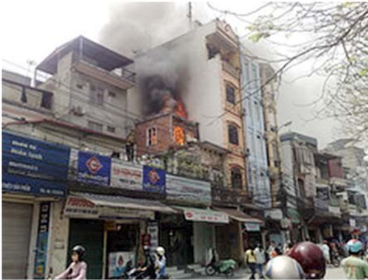
Cháy nhà do đốt vàng mã.
