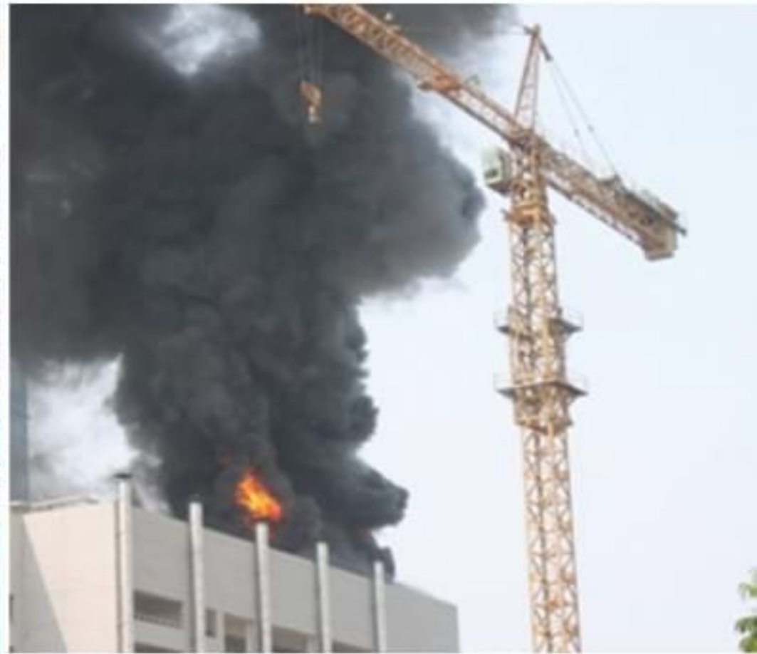
Cháy tại công trình tòa nhà Keangnam Landmark Tower, đường Phạm Hùng, Hà Nội (27/8/2011)
