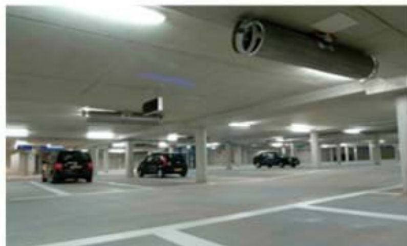
Hình 1. Hệ thống quạt "impuls" trong tầng ngầm để xe
