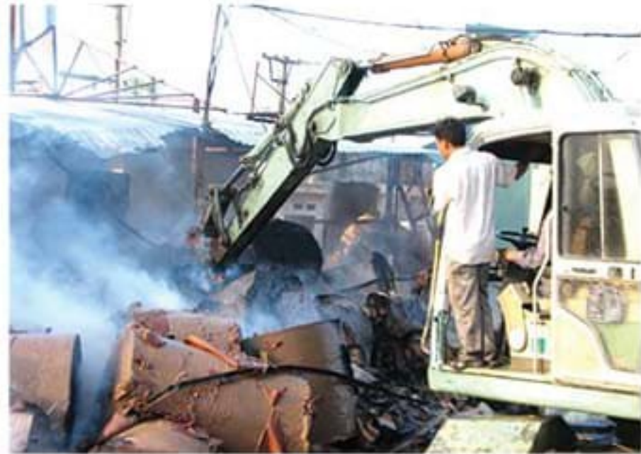
Cháy tại Khu công nghiệp Cầu Diễn, Hà Nội.
