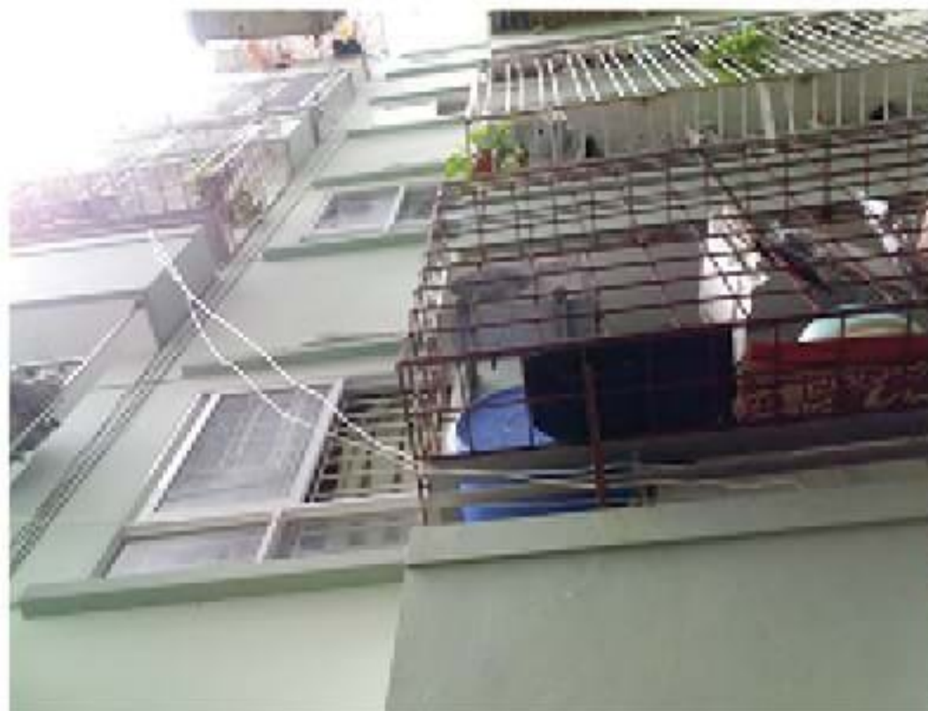
Dây điện chằng chịt, có thể xảy ra chập cháy bất cứ lúc nào
